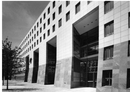
Das IKB-Gebäude in Düsseldorf. Bild: IKB Deutsche Industriebank AG
